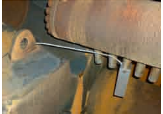
Installationsbeispiel: Drucksensor mit Spritzschutz montiert auf Spritzbalken
