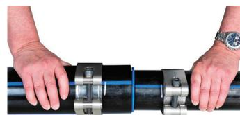
Zweites Rohr bis zum Anschlag auf die Reduktion schieben.
