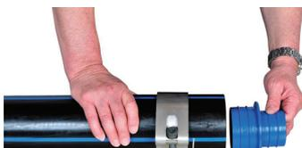
Reduktion bis zum Anschlag in das Rohrende schieben.
