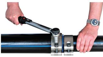
Schrauben mit dem Drehmoment-schlüssel auf das angegebene Anzugs-moment anziehen.
