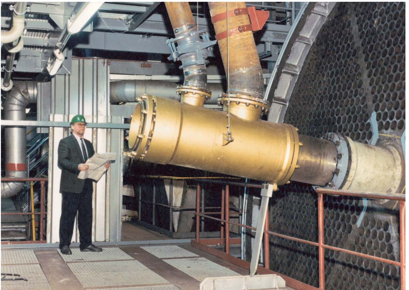
Baureihen H und DC: Geeignet für besonders große Dampfmenen. Lieferbar bis DN 350.
